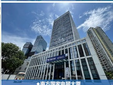
●南方国家电网大厦
